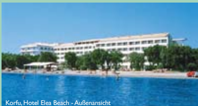
Korfu, Hotel Elea Beach - Außenansicht
